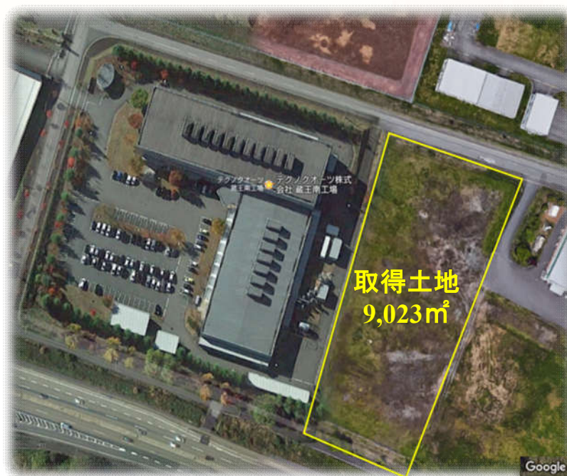
蔵王南工場の隣接地(新工場建設予定地)
