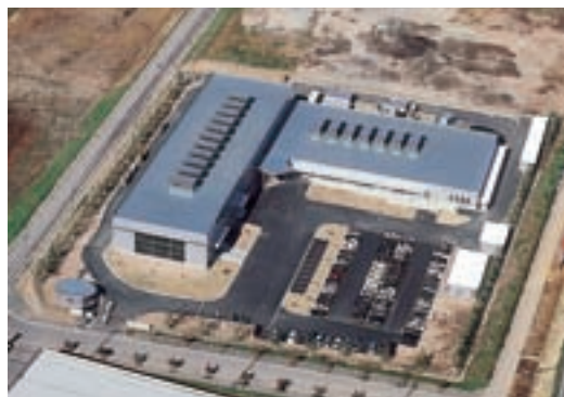
蔵王南工場（山形県山形市）
